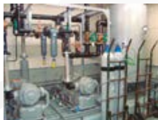
Figuras 18 e 19: Central de Ar Comprimido e Central de Vácuo Clínico
