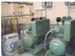
Figuras 18 e 19: Central de Ar Comprimido e Central de Vácuo Clínico
