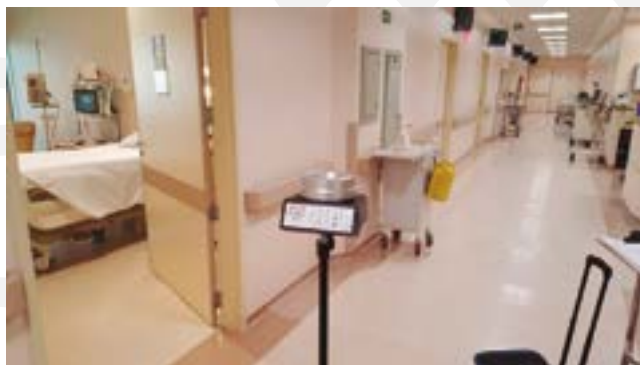
Figura 1: UTI – Hospital “A”, medição com o local em operação normal.
