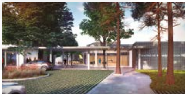
Vista desde el ingreso
